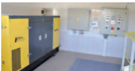
Szafki sterownicze i agregat prądotwórczy
